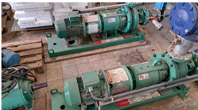
Obr. 3. Čerpadla Vaughan v okruhu malé cirkulace
